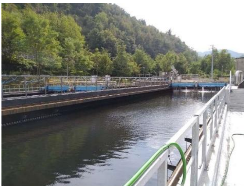
depuratore di Ronco Scrivia
