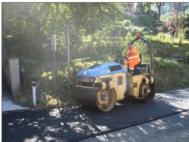
**Figura 18** - Stesura di asfalto fonoassorbente nel tratto in esame lungo la SP 225
