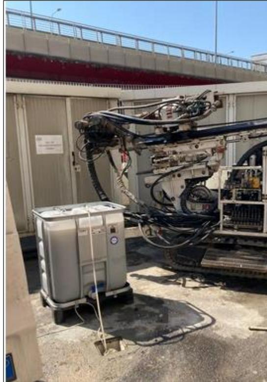
Figura 6: Gestione delle operazioni di spurgo con stoccaggio delle acque sotterranee come rifiuto
