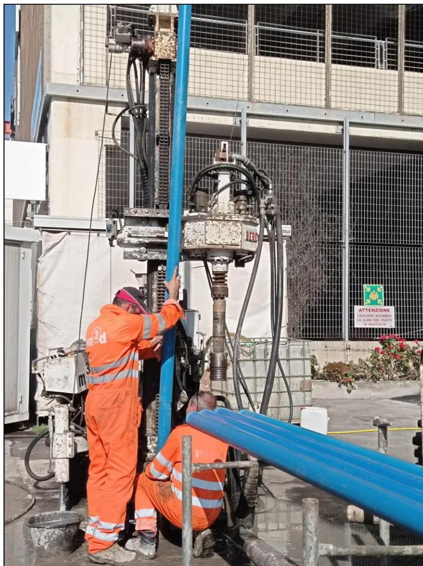
Figura 5: Fasi operative durante le operazioni di posa dei tubi piezometrici
