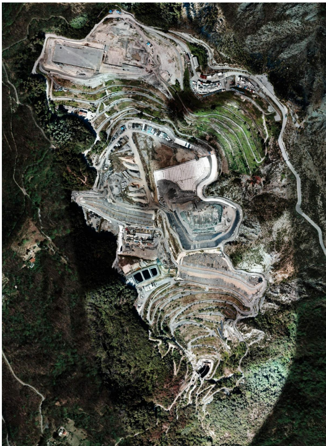
Immagine aerea dell'area della discarica (anno 2021)
