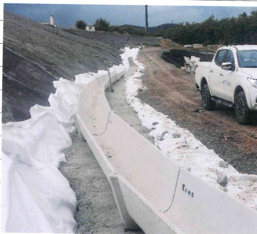
Foto 6 – Foto dell'avanzamento delle lavorazioni di posa della canaletta nella prima sponda inferiore di collegamento tra la parte alta più pianeggiante della discarica e la parte bassa
