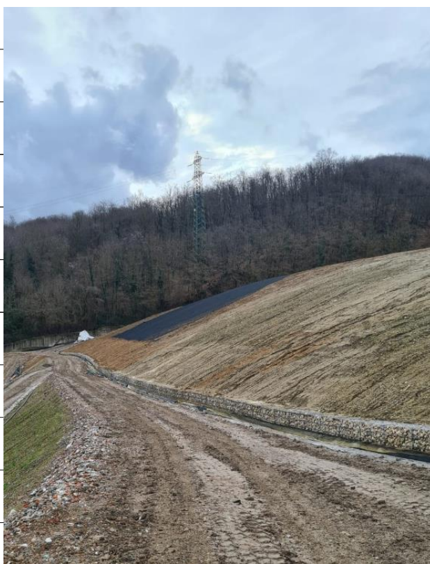
Foto 2 – Innalzamento pista adibita alla viabilità interna della discarica
