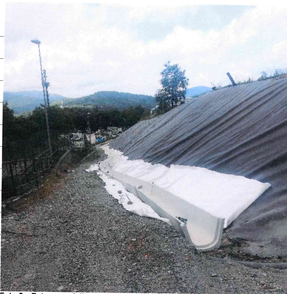
Foto 5 – Foto posa della canaletta zona ovest della discarica
