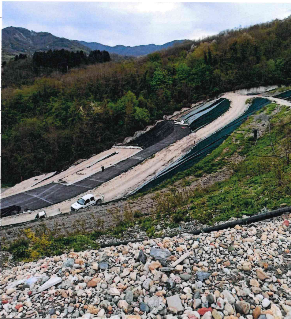
Foto 1 – Foto generale dell'area della discarica Birra a Busalla
