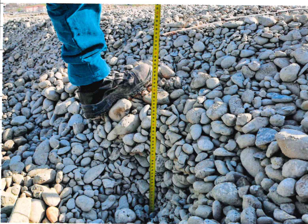
Foto 2 – Foto prova di collaudo T1 del materiale inerte per lo strato di drenaggio del biogas
