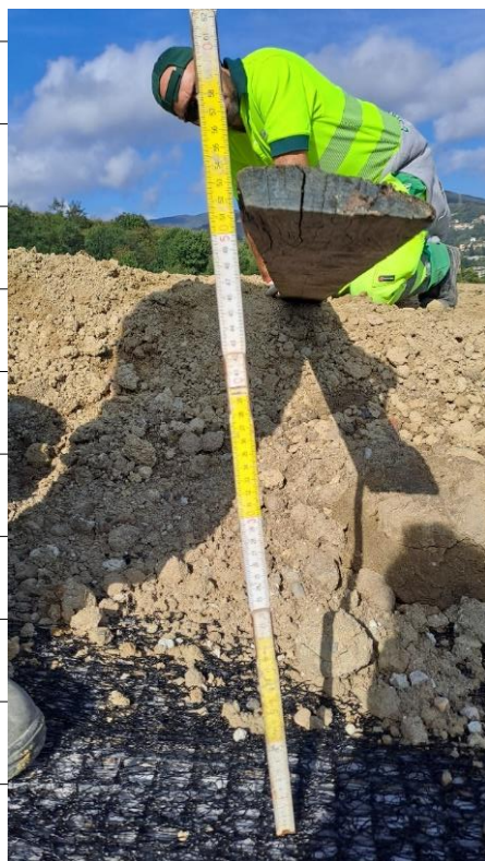
Foto 5–Esecuzione prova di spessore T1
