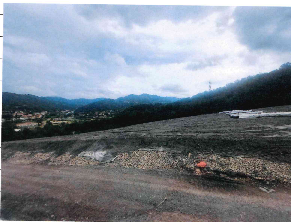
Foto 2 – Foto completamente della posa del materiale minerale compatto a bassa permeabilità (limo)
