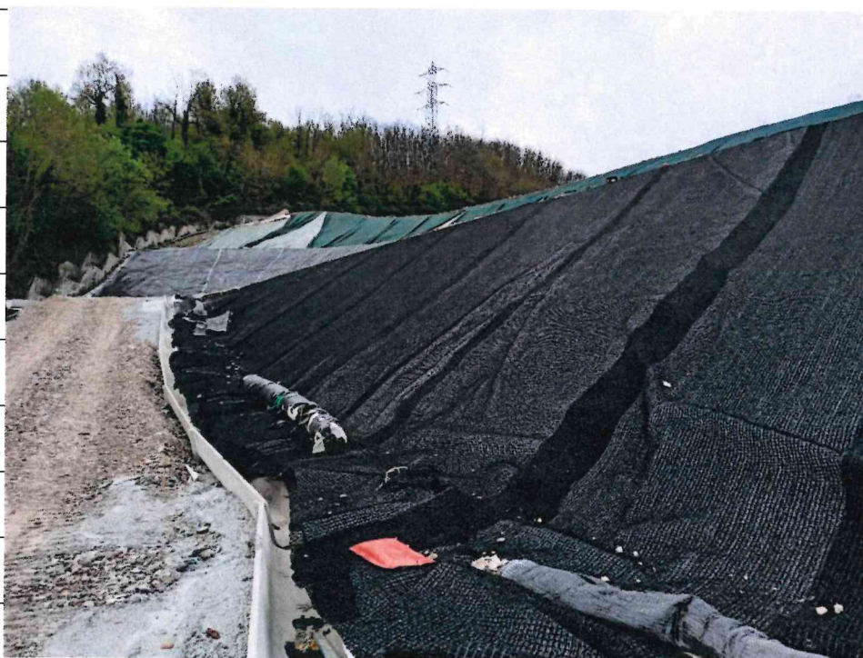
Foto 2 – Foto sovrapposizioni verificate geocomposito bentonitico
