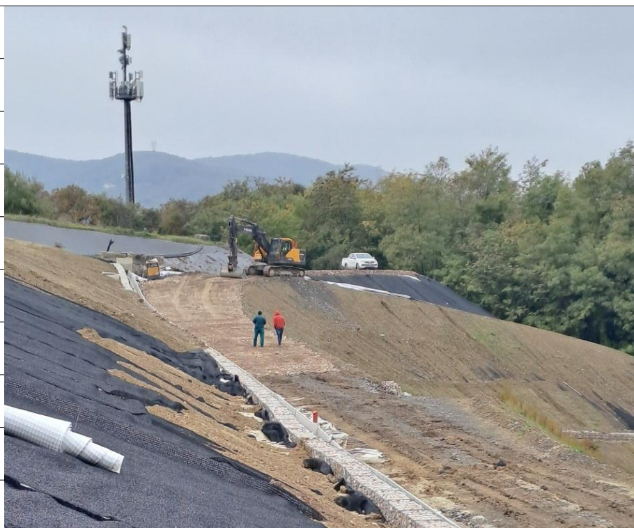
Foto 4 – Innalzamento pista adibita alla viabilità interna della discarica
