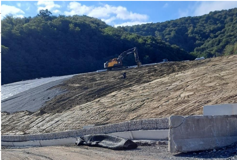
Foto 1 – Avanzamento delle lavorazioni di posa dello strato colturale
