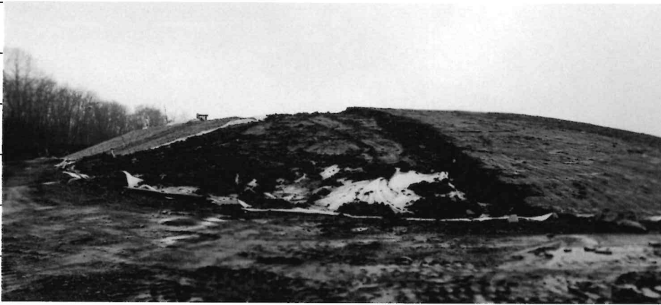
Foto 3 e 4 – Foto avanzamento della posa del materiale minerale a bassa permeabilità
