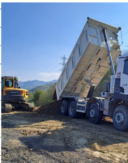
Foto 2 – in corso scarico materiale per realizzazione piste per la viabilità interna
