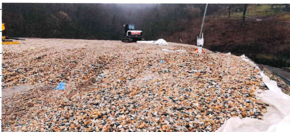
Foto 1 e 2 – Foto completamente della posa del materiale inerte per lo strato di drenaggio del biogas
