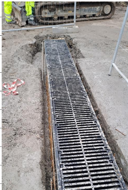
Foto 2 – nuovo tratto di canale grigliato per la regimazione acque meteoriche dell'area servizi della discarica
