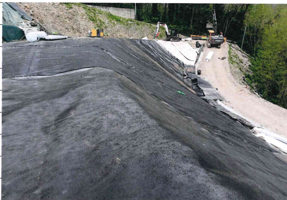
Foto 2 – Foto posa teli geomembrana in HDPE
