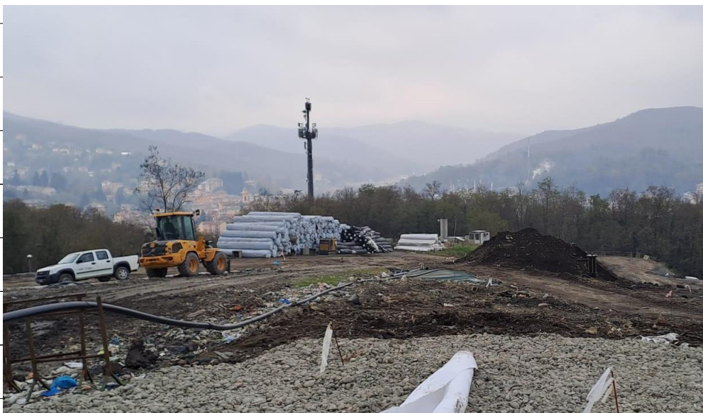
Foto 4 – Foto area stoccaggio materiali (geotessuti non tessuti)
