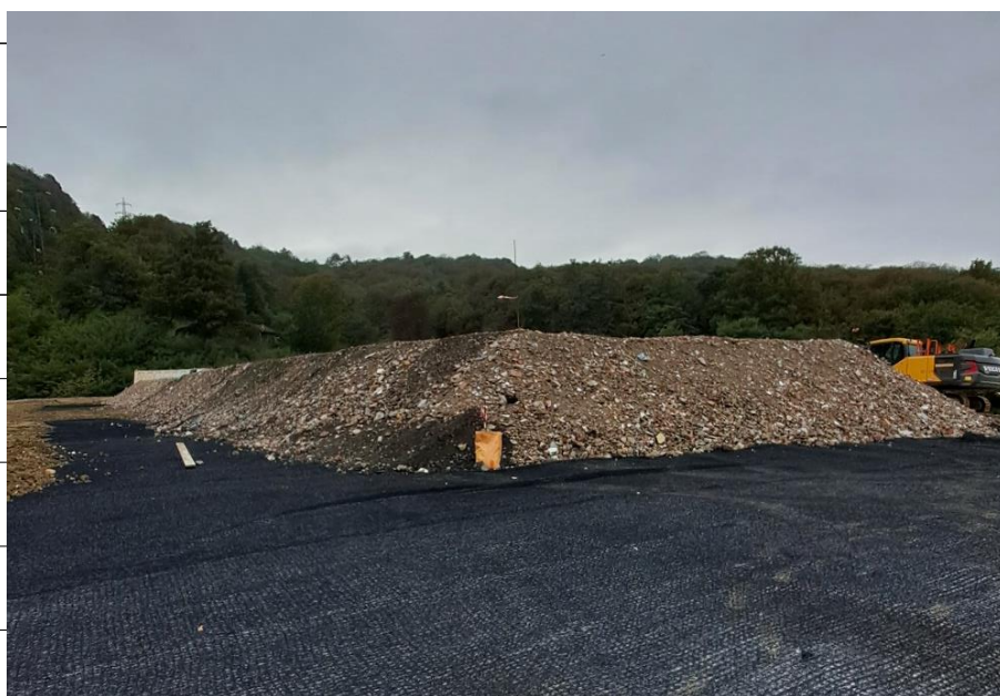
Foto 6– Avanzamento lavorazione per alloggiamento dei serbatoi espansibili di raccolta percolato
