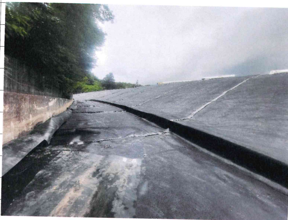
Foto 3 – Foto avanzamento delle lavorazioni di posa dello strato di geomembrana in HDPE di tipo ruvido/ruvido
