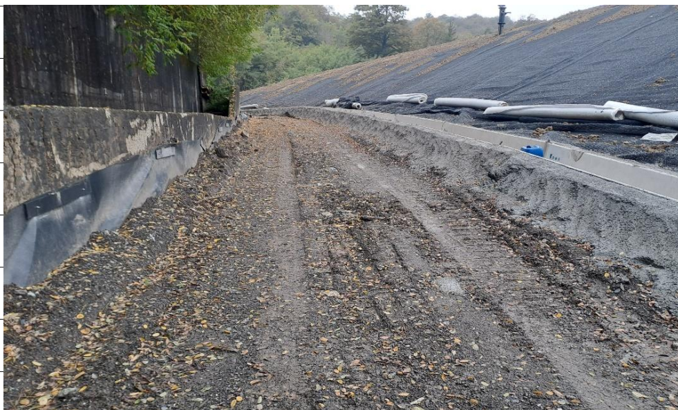
Foto 9– fissaggio dei teli di HDPE sulla sponda esterna del canale di gronda
