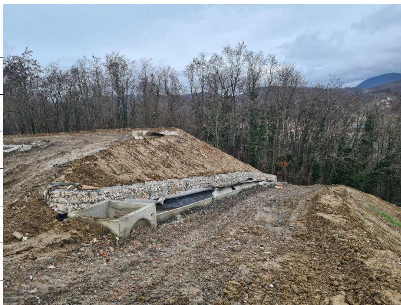
Foto 4– sistemazione area in prossimità della zona di ingresso alla discarica, a monte della zona nord
