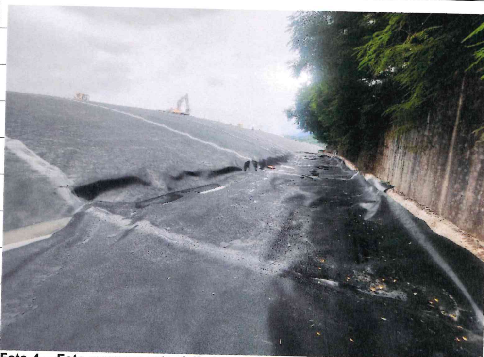
Foto 4 – Foto avanzamento delle lavorazioni di posa dello strato di geomembrana in HDPE di tipo ruvido/ruvido
