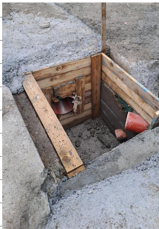
Foto 3 – nuovi pozzetti di confluenza delle tubazioni di raccolta delle acque meteoriche afferenti al piazzale servizi della discarica
