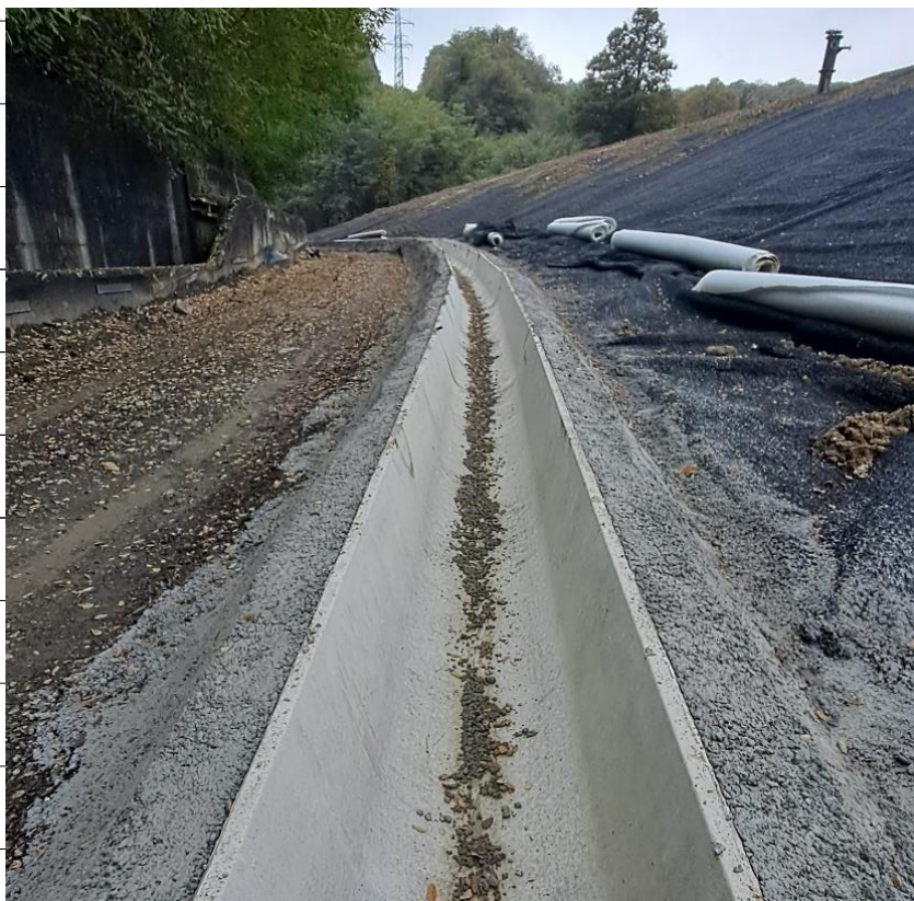
Foto 8 – Canaletta prefabbricate per la regimazione delle acque meteoriche
