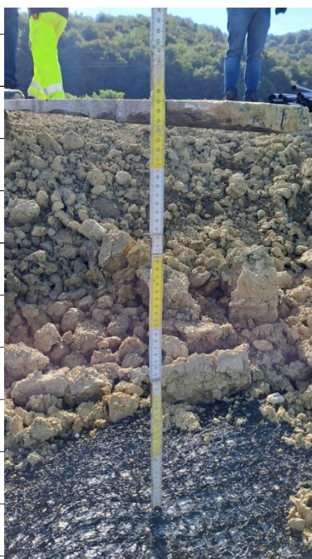
Foto 6–Esecuzione prova di spessore T2
