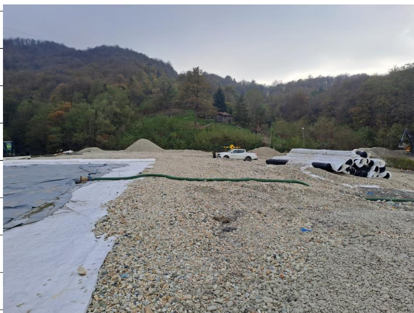
Foto 1 e 2 – Foto generale dell'area di posa del materiale inerte per lo strato di drenaggio del biogas
