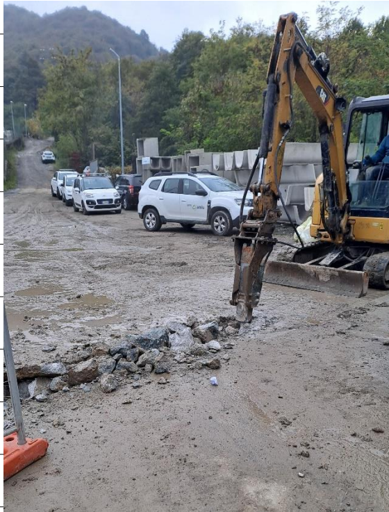
Foto 1 – Avanzamento delle lavorazioni di rottura del manto superficiale per impianto regimazione acque meteoriche dell'area servizi della discarica
