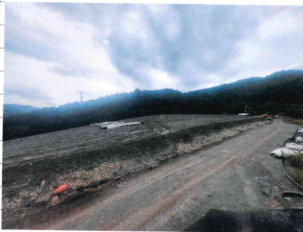
Foto 1 – Foto completamente della posa del materiale minerale compatto a bassa permeabilità (limo)
