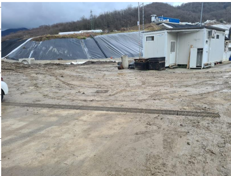
Foto 1 – Completamento delle lavorazioni per la regimazione acque meteoriche nell'area servizi all'ingresso della discarica
