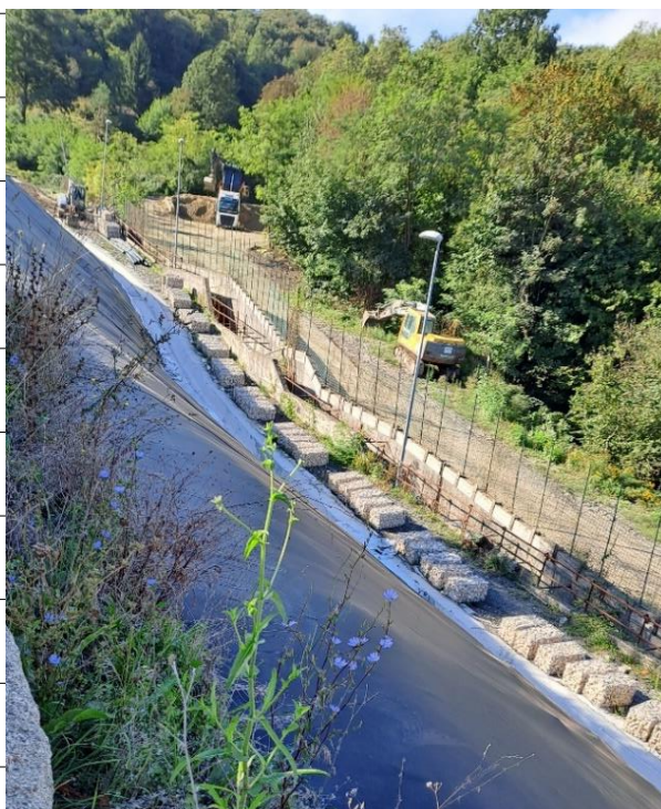
Foto 3–Gabbioni metallici in alloggiamento temporaneo in fase di lavorazione
