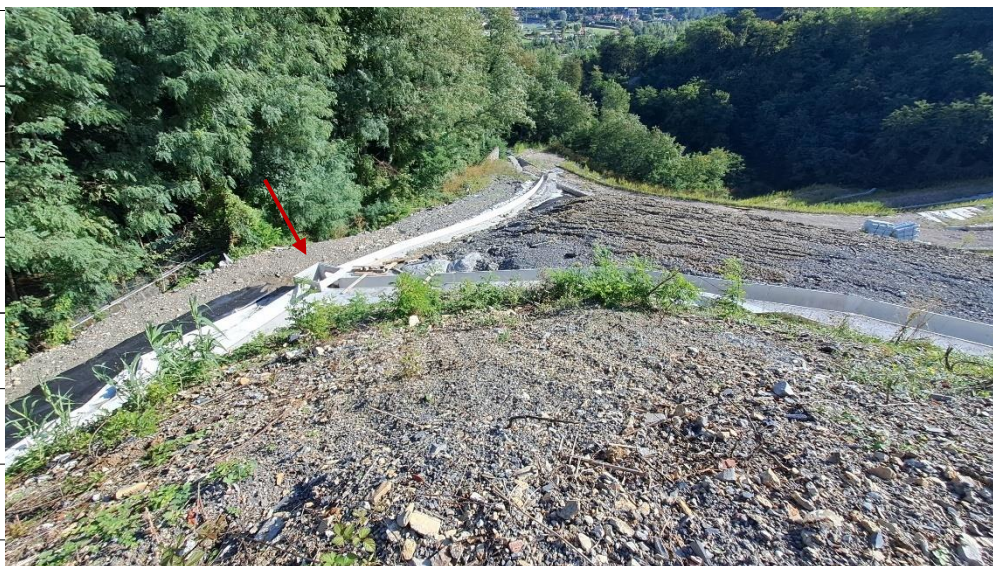
Foto 8 – Canalette prefabbricate e relativo pozzetto di innesto per la regimazione delle acque meteoriche
