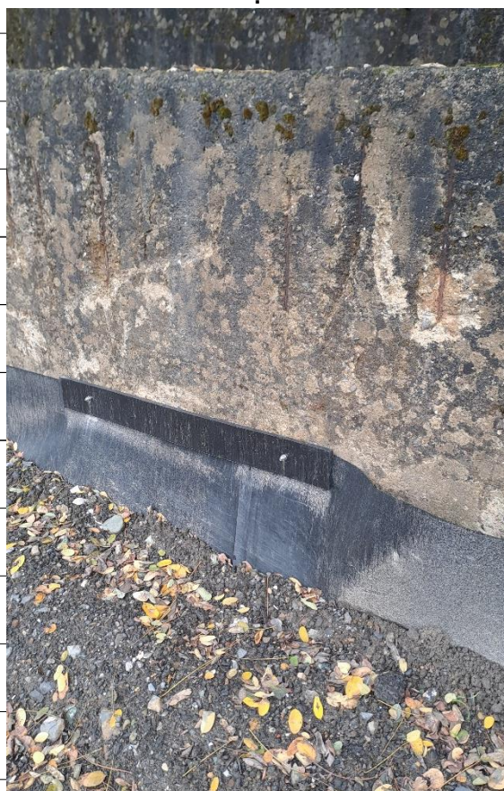
Foto 10– dettaglio piastra HDPE per fissaggio dei teli di HDPE
