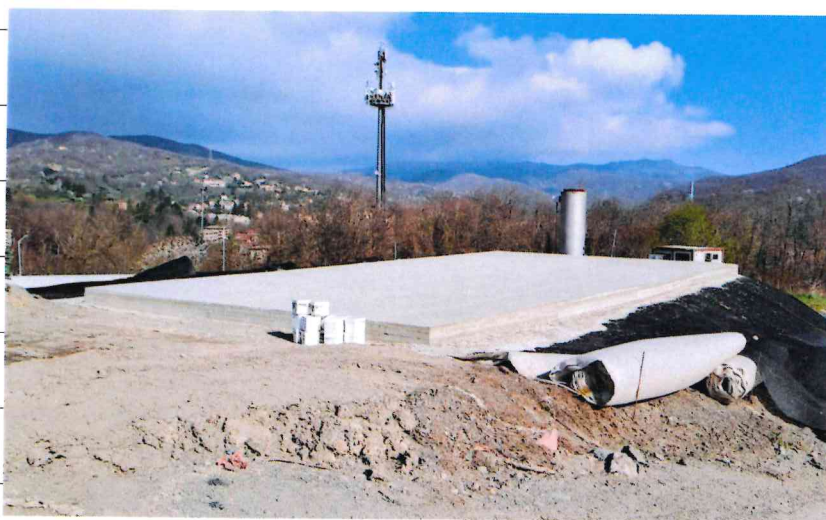
Foto 8 – Foto completamente della realizzazione della platea di fondazione in cemento armato di alloggiamento per la nuova torcia del sistema di aspirazione del biogas
