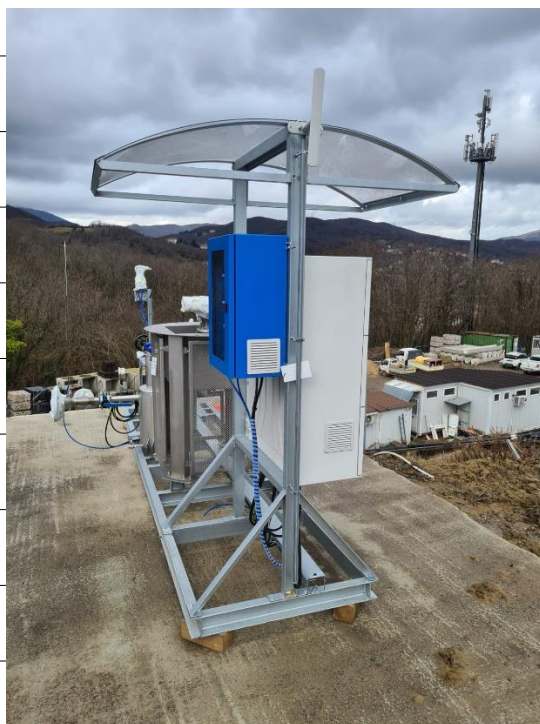
Foto 5– Sistema aspirazione e combustione biogas
