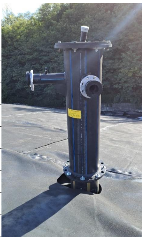
Foto 4–Innalzamento pozzo biogas con taglio della geomembrana HDPE per successiva lavorazione di sigillatura intorno allo stesso
