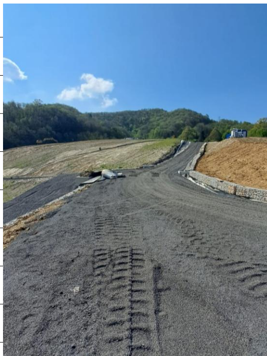
Foto 1 – Avanzamento realizzazione piste adibite alla viabilità interna della discarica
