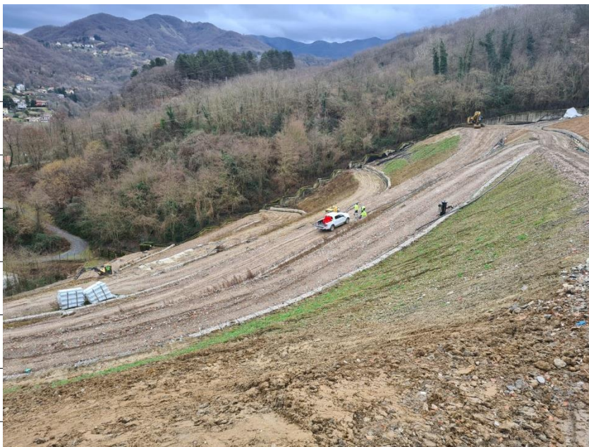
Foto 3– Veduta complessiva zona nord post ricarica di terreno colturale
