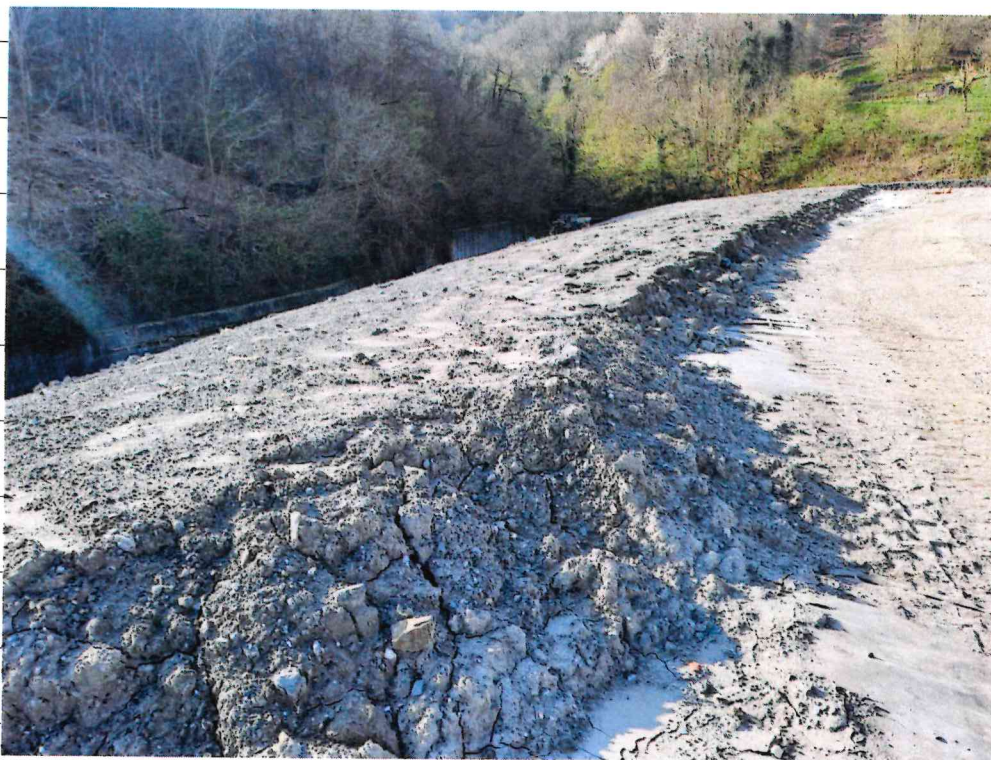
Foto 5 – Foto dell'avanzamento delle lavorazioni di posa dello strato di materiale minerale compatto a bassa permeabilità (limo)
