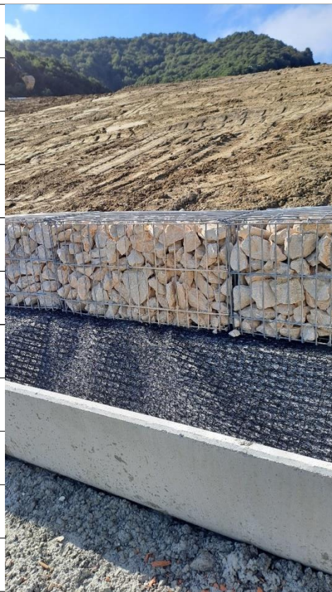
Foto 2 – Gabbioni metallici in alloggiamento definitivo
