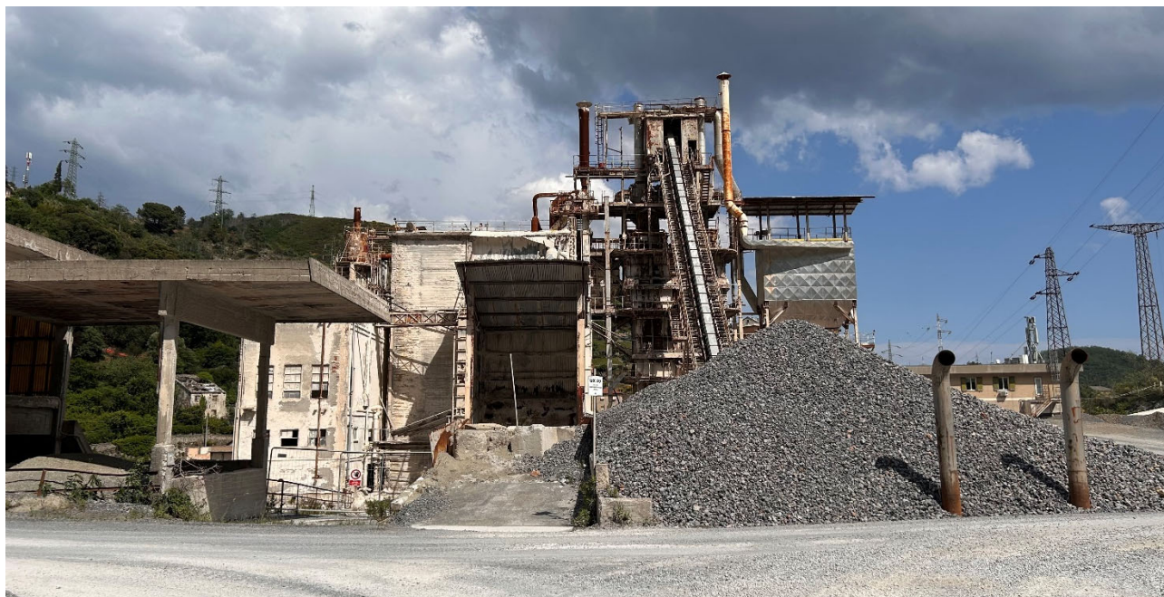
Foto 2 – Vista della zona tramogge di carico dei forni.
