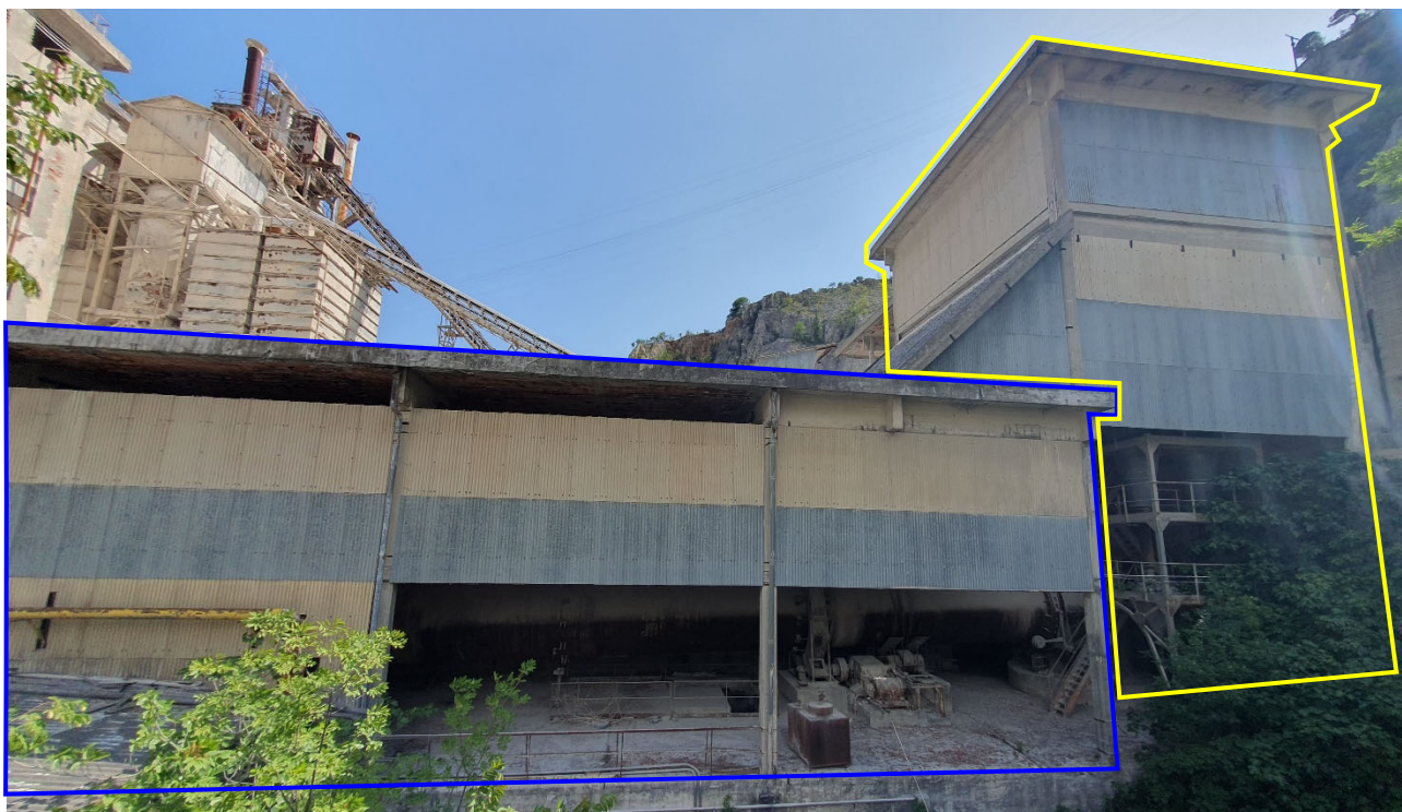
Foto 4 – Torre con tramoggia di carico del forno rotativo (in blu) e fabbricato ospitante il forno rotativo (in giallo).
