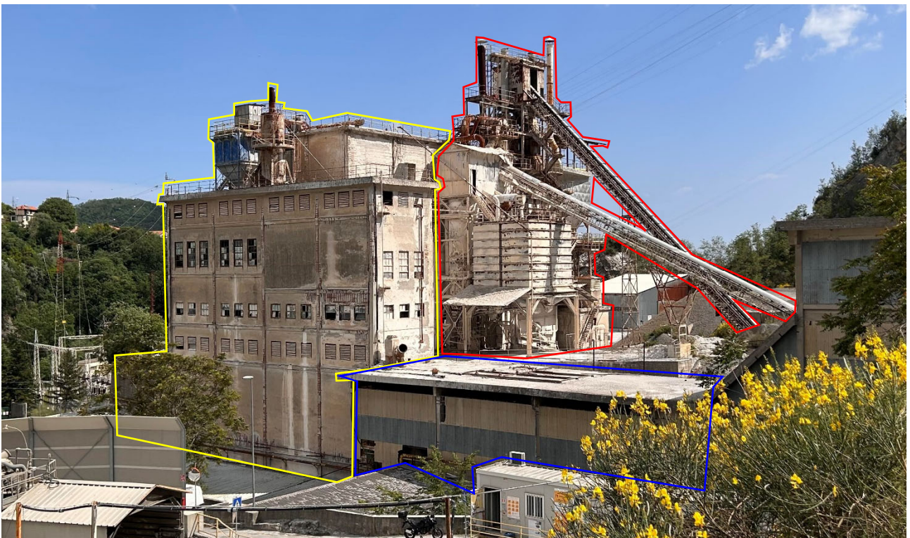
Foto 5 – Vista del reparto idratazione (in giallo), del forno rotativo (in blu) e del forno verticale (in rosso).
