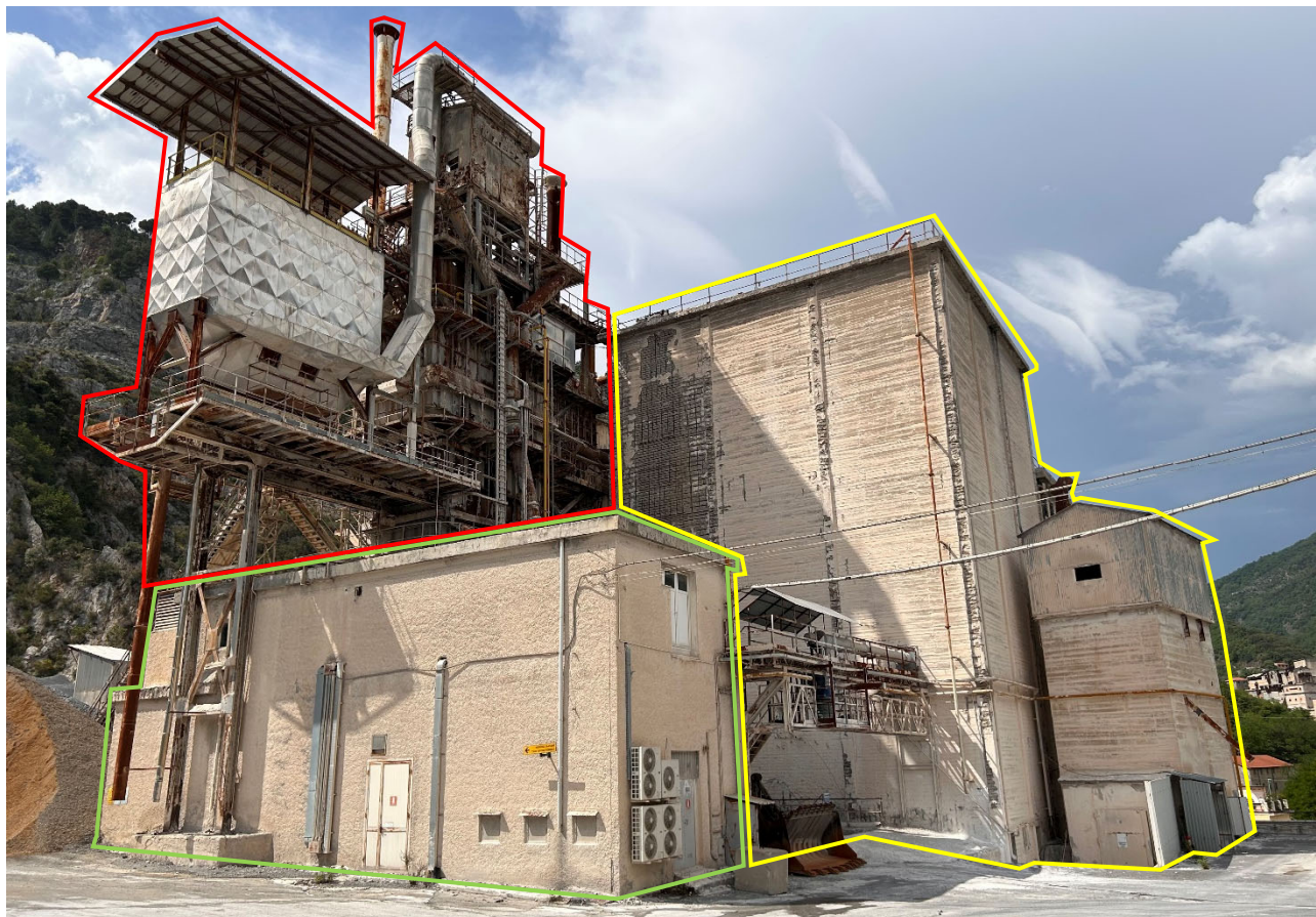
Foto 3 – Vista d’insieme del forno verticale Maerz (in rosso), della cabina di elettrica MT/BT (in verde) e del fabbricato contenente i silos di stoccaggio della calce idrata (in giallo).
