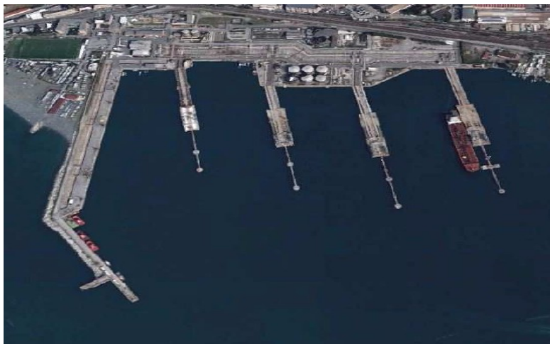
Fig.1. Vista aerea dell'impianto.
