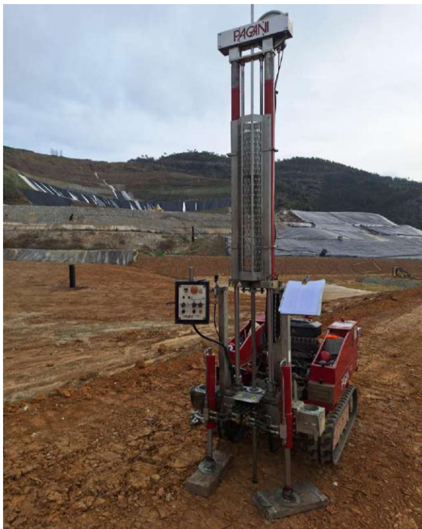
Foto 1: realizzazione prova Dpsh1.
