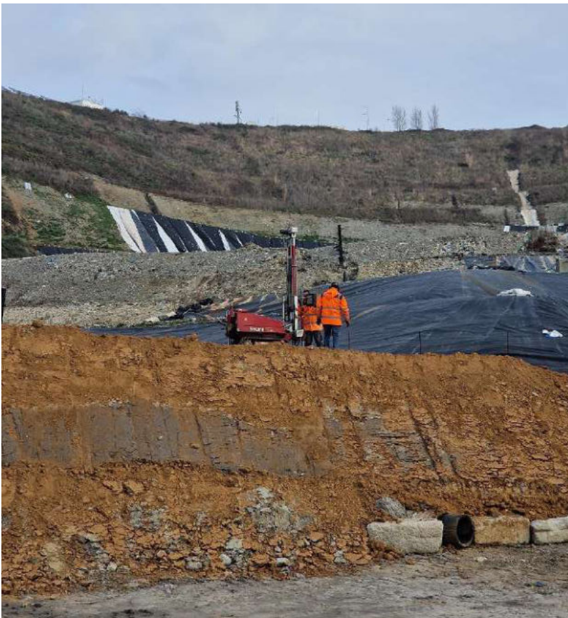
Foto 3: realizzazione prova Dpsh3.
