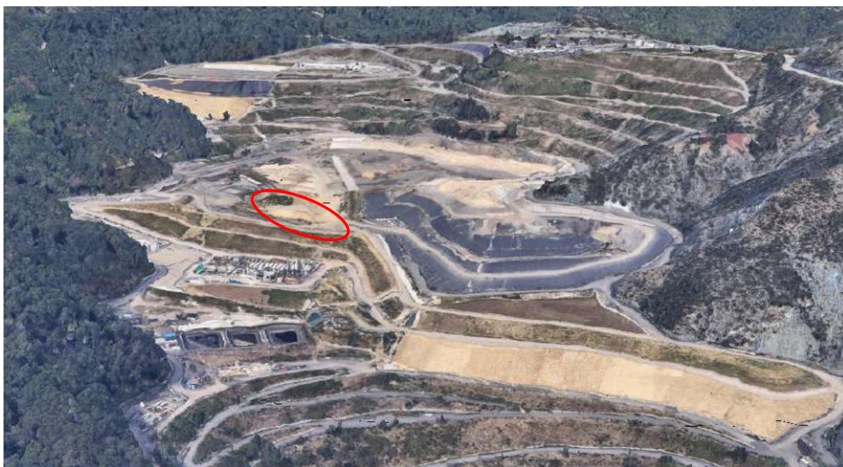
Fig. n°10: panoramica area d'intervento.
